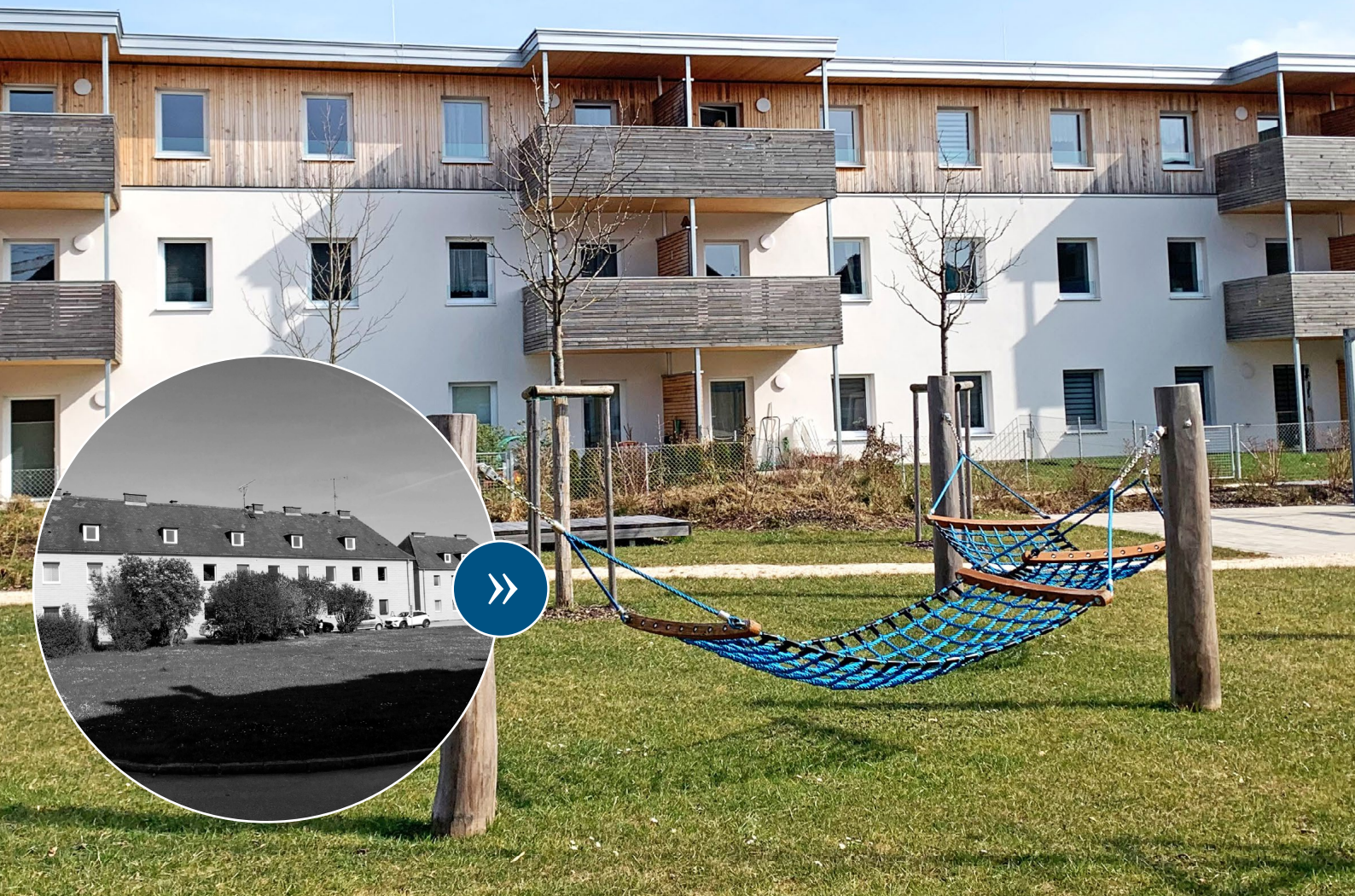
Weidenweg Wels: Wohnanlage vorher / nachher
