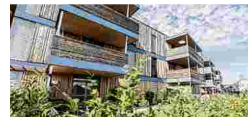
Anlage in Wels-Lichtenegg
