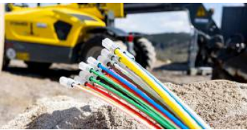
Noch vor Sommer starten die Bauarbeiten in Obernberg. Foto: Quelle öGIG
