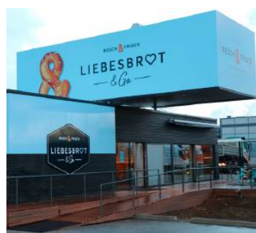
Ansicht der neuen Filiale in Gunskirchen.
