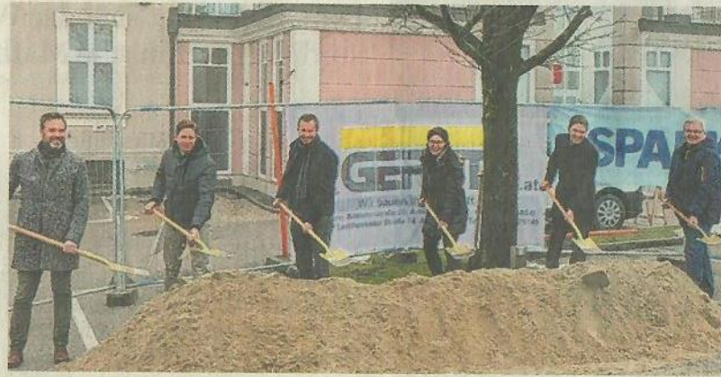
Beginn für den Tiefgaragenbau: Gerold Wimmer, Johann Lenz, Dieter Greiner, Sparkassenvorstände Ulrike Edelsbacher und Christian Ohlwerter, Johannes Moser
