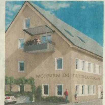
Das ehrwürdige Guttmanhaus aus dem 16. Jahrhundert wird saniert
